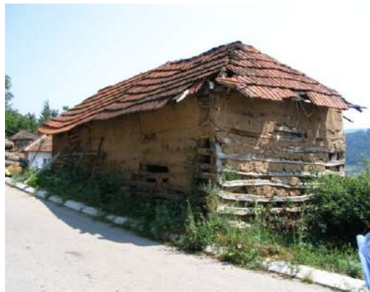
Сл.157 Бондрук испуњен приковцима и бла- том, стаја из околине Медвеђе (извор: аутор)
