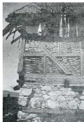
Сл.173 Испуна бондручног система, детаљ Krunić , Kuća i varoši u oblasti Stare Raške c.92)
