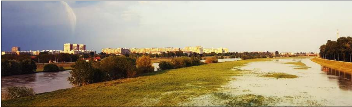
Sl. 98: grad Zagreb - postojeće stanje rečno priobalje Save, pogled s desne (novozagrebačke) obale i od središnjega gradskog Mosta slobode, ka istoku (Foto: autor, 2017.)
