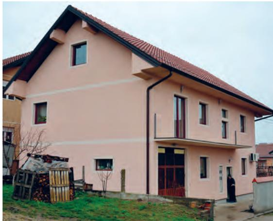
Породична кућа са масивним зидовима од опеке и фасадом изведеном у виду „контактне“ термоизоловане фасаде. На термограму се уочава нижа температура зида негрејаног тавана као и губици топлоте на местима продора конзолних тераса кроз термички омотач, односно у зони стрехе. Конструкција прозора и улазних врата је неодговарајућа са приметним топлотним губицима.
