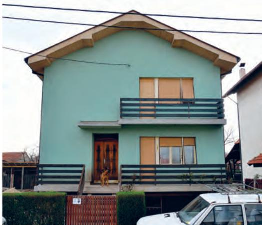
Породична кућа са масивним зидовима од опеке и фасадом накнадно изведеном у виду „контактне“ термоизоловане фасаде коришћењем полистиренских блокова. На термограму се уочавају губици топлоте на местима продора конзолних тераса кроз термички омотач и у зони стрехе. Конструкција прозора и улазних врата је неодговарајућа са приметним топлотним губицима.
