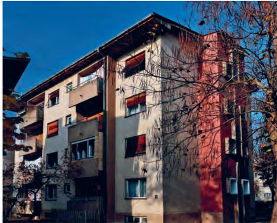
Стамбена зграда са масивним фасадним зидовима од опеке без термоизолације. Термограм приказује приметне губитке топлоте кроз фасадни зид нарочито у зонама хоризонталних армирано бетонских серклажа, натпрозорних греда и на местима конзолно препуштених тераса. Оригинална фасадна столарија је у лошем стању и карактерише се изразитим губицима на спојевима оквира и у зони кутија за ролетне.
