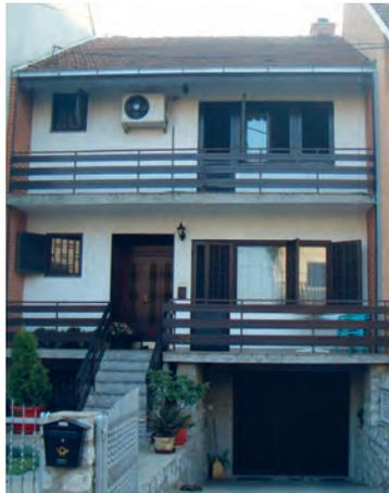
Породична кућа у низу са масивним фасадним зидовима од опеке без термоизолације. Кућа се греје у целости и на термограму се јасно може видети грејани део у односу на негрејани тавански простор. Најизраженији губици топлоте се јављају у зони армирано бетонских серклажа и натпрозорних греда. Конструкција прозора и врата је неодговарајућа са изразитим топлотним губицима.
