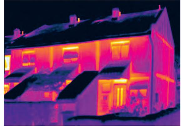
Породичне куће у низу са масивним зидовима од опеке и изолационим слојем у виду термоизолационог малтера. На термограму се уочавају изразити губици у зони армирано бетонских серклажа. Конструкција улазних врата и прозора је неадекватна са приметним топлотним губицима нарочито у зони кутије за ролетне. Поткровни простор се не греје.
