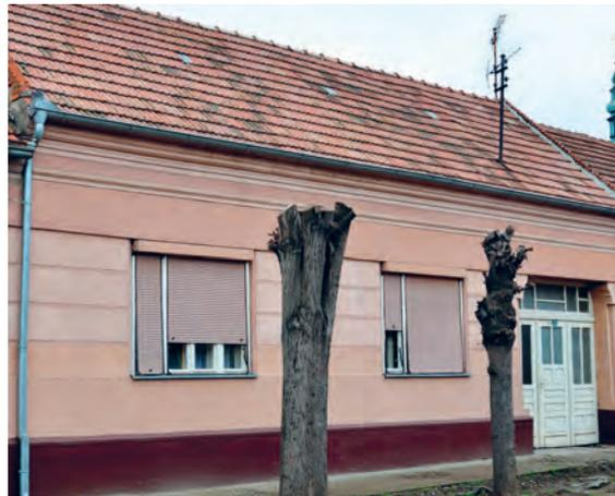
Породична кућа са масивним фасадним зидовима од опеке без термоизолације. Кућа се не греје у целисти и на термограму се јасно може видети грејани део у виду леве собе на уличној фасади. Приметна загрејаност кровне површине се јавља као последица сунчевог зрачења. Конструкција прозора је неодговарајућа са изразитим топлотним губицима, нарочито у зони кутија за ролетне.
