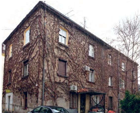
Стамбена ламела са изразито масивним фасадним зидовима од опеке без термоизолације. Термограм приказује равномерне губитке топлоте кроз фасадне зидове са повећаним интензитетом у зони натпрозорних греда (и код зазиданог отвора приземља). Поједини прозори су замењени савременим од ПВЦ профила и добрих су термичких карактеристика док се оригинални карактеришу изразитим топлотним губицима.
