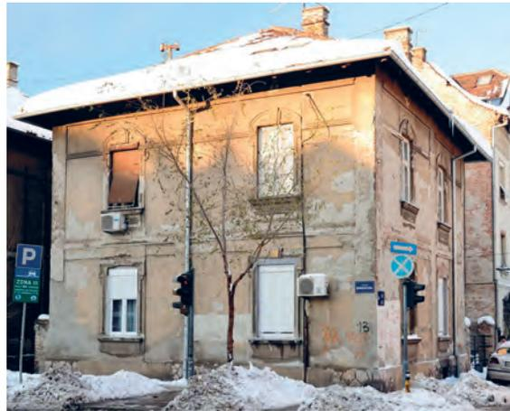
Стамбена зграда са изразито масивним, хомогеним, фасадним зидовима од опеке без термоизолације. Термограм приказује равномерне губитке топлоте кроз фасадне зидове који су изведени без армирано бетонских серклажа. Поткровни простор је накнадно усељен и термички изолован. Конструкција прозора са приметним топлотним губицима.
