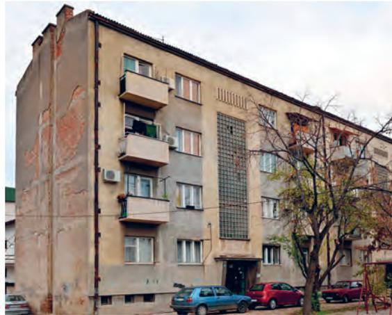
Стамбена ламела са масивним фасадним зидовима од опеке без термоизолације. Термограм приказује различите интензитете губитака топлоте кроз фасадне зидове на местима армирано бетонских серклажа и зидане испуне. Такође је уочљива разлика између негрејаног простора тавана односно стана у приземљу и осталог, грејаног дела зграде. Фасадна столарија се карактерише изразитим губицима топлоте.
