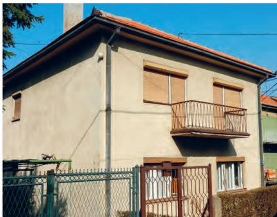
Породична кућа са масивним фасадним зидовима од опеке без термоизолације. Кућа се не греје у целости и на термограму се јасно може видети грејани део у виду приземне етаже. Најизраженији губици топлоте се јављају у зони хоризонталних армирано бетонских серклажа и натпрозорних греда. Конструкција прозора је неодговарајућа са изразитим топлотним губицима, нарочито у зони кутија за ролетне.
