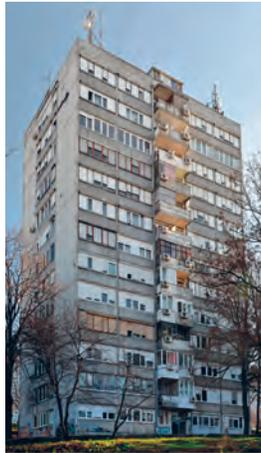
Стамбени солитер са пуним фасадним зидовима од бетона или шљако блокова без термоизолације и тракама лаких парапетних зидова и прозора. Термограм приказује приметне губитке топлоте кроз бочне масивне зидове нарочито у зонама серклажа и на спојевима парапетних зидова и прозора. Метална облога парапета услед високе рефлективности карактерише се нереално ниским температурним читавањима.
