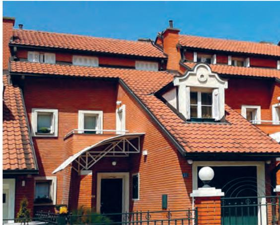
Породична кућа у низу са масивним фасадним зидовима од гитер блока, термоизолацијом и обзидом од фасадне опеке. Кућа се греје у целости а на термограму може видети униформно понашање уз одсуство изразитих линијских губитака. Термичке перформансе зидова као и конструкција прозора и врата су у складу са, за то доба, важећим прописима из области топлотне заштите.
